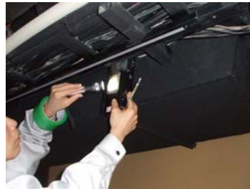
▲ダクトの接続部をセンサーで測定
