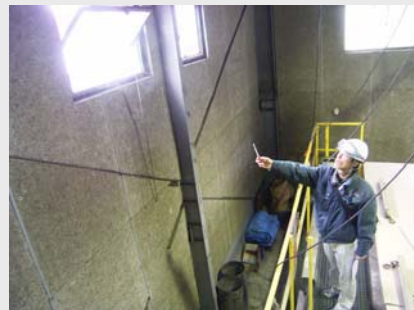
臭気発生源付近の気流を調査します。
