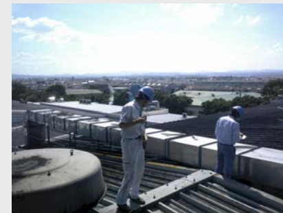
臭気発生状況を調査・記録します。
